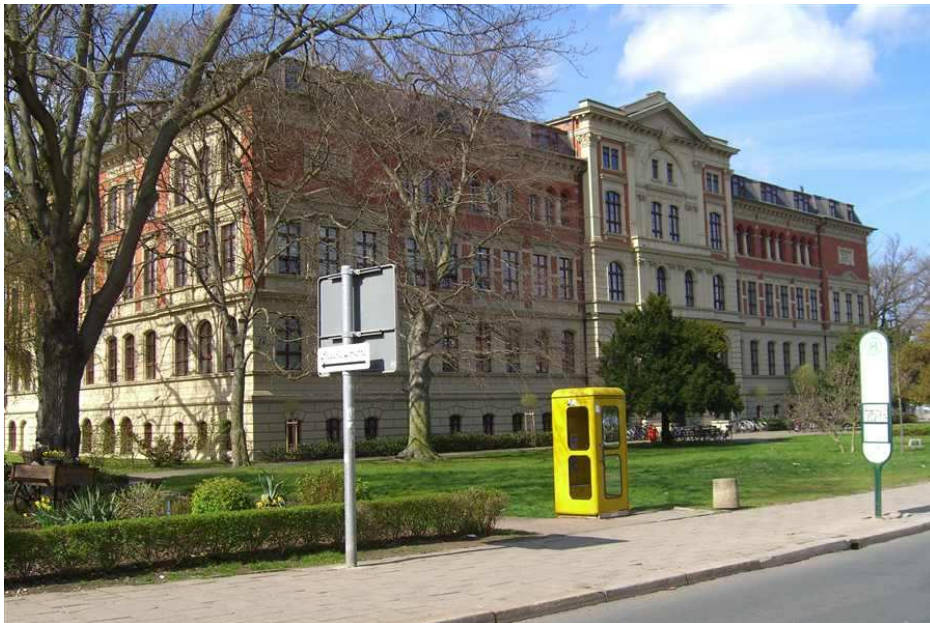
Figura 2: Edificio principal de la Hochschule Anhalt en Köthen
